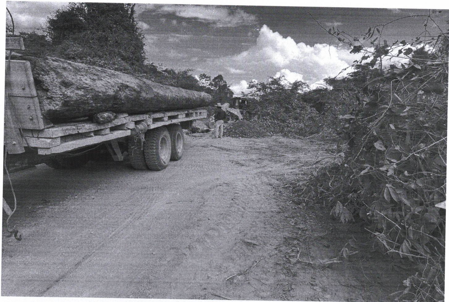
troca da ponte na MT 160
