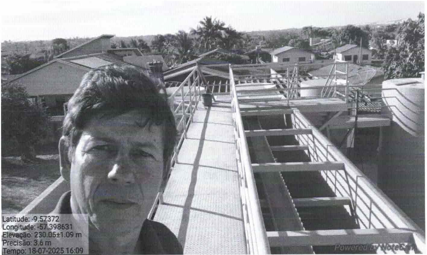
Visita estação tratamento de água
